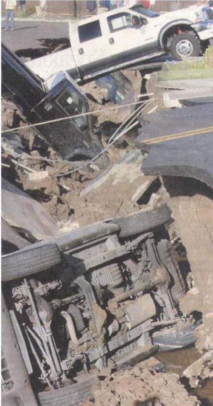
**FIGURE 3 : Affaissement de la chaussée à Bakersfield, Californie**
