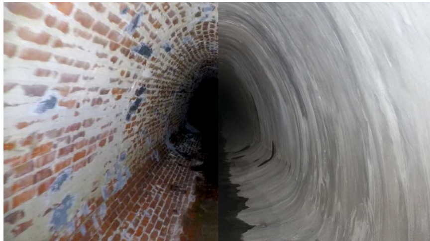
Figure 7 | Méthode de correction de projection de géopolymère, existant versus correctif, tuyau ovale (Ref. Vortex Companies)
