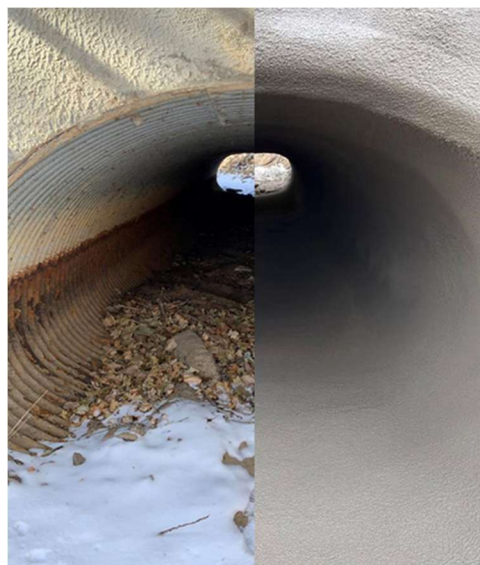
Figure 8 | Méthode de correction de projection de géopolymère, existant versus correctif, tuyau circulaire (Ref. Vortex Companies)
