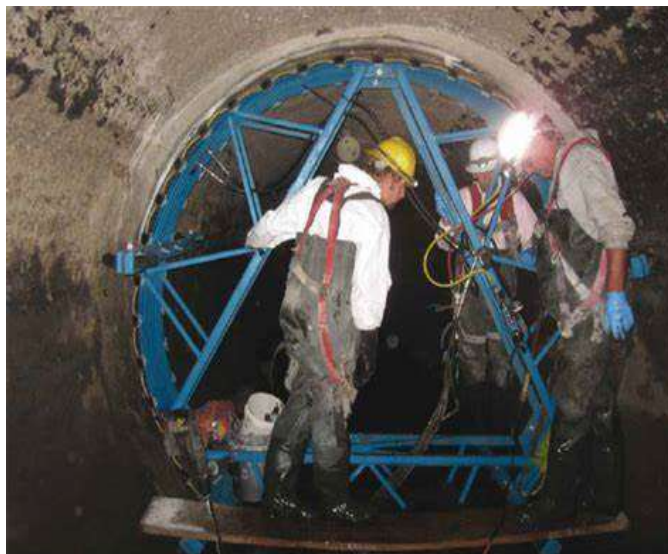
Figure 3 | Méthode corrective de colmatage chimique, intervention à l'intérieur du tuyau (ref. Logiball)
