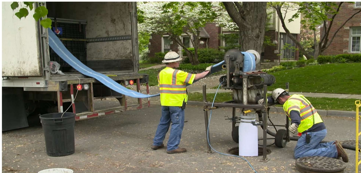
Figure 5 | Méthode corrective de chemisage ponctuel, insertion de la gaine (réf. City of Greeley)
